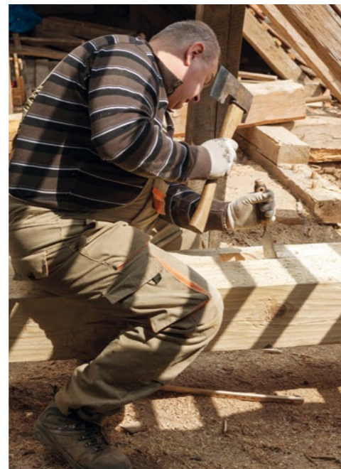
▲ Oprava krovu na zámku Brtnice – ruční výroba tesařských spojů. Foto Viktor Mašát
